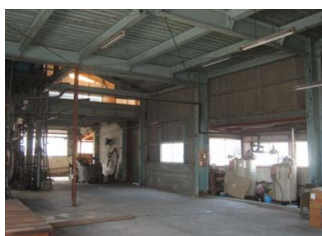
工場・倉庫1階西側
