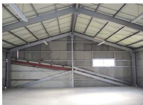
工場・倉庫2階南側
