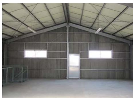
工場・倉庫2階北側
