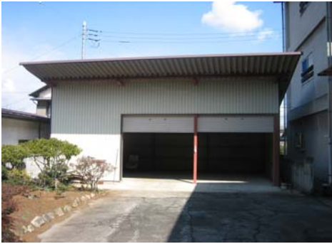
倉庫外観写真
