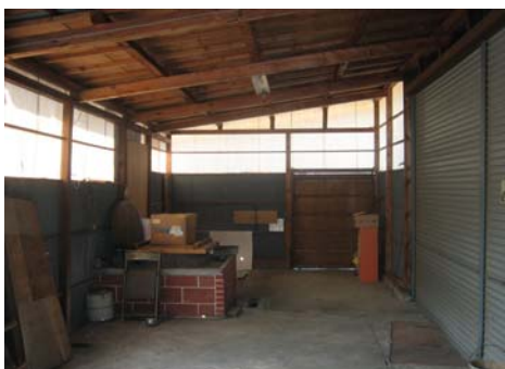
工場・倉庫1階西側出張部分
