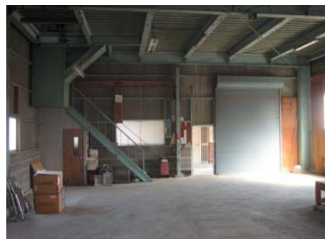
工場・倉庫1階北側
