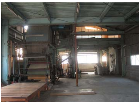
工場・倉庫1階南側
