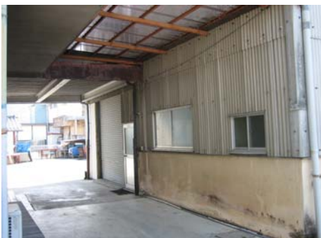
工場・倉庫入口部外観写真
